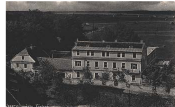
Městské lázně v roce 1940 hlavní lázeňská budova prošla rekonstrukcí
