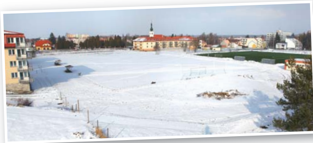
↑ Místo pro výstavbu nového sportoviště u Lázní Aurora.
