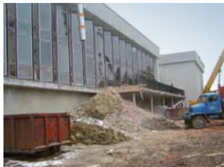
Bourací práce u jižní stěny
