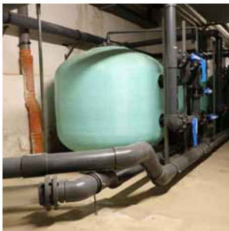
Filtry plaveckého bazénu. Každý bazén má své filtry pro čištění bazénových vod
