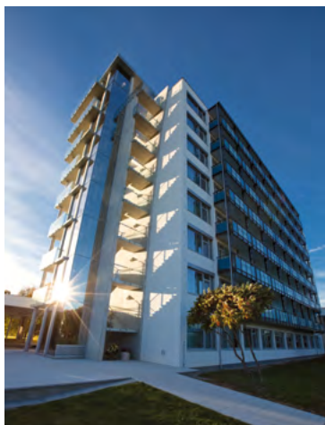
Hlavní budova A s panoramatickým výtahem
