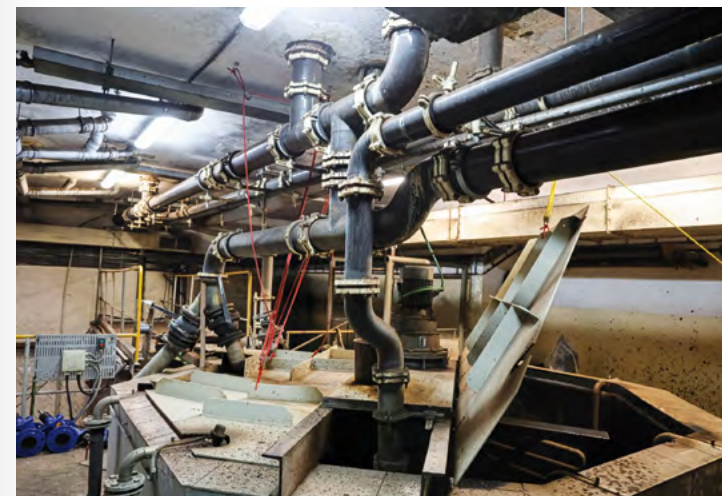
Skleněné potrubí. Slatina se v LD Aurora rozvádí skleněným potrubím, jehož celková délka je přibližně 250 metrů. Takto putuje již půl století
